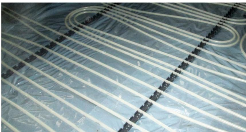
Verlegen Sie die Wärme- und Trittschalldämmung, eine eventuell notwendige Feuchtigkeitssperre unterhalb der Dämmung und die Kunststoffolie gleich wie bei der Variante „Gittermatte“ anzuordnen und zu verlegen.
